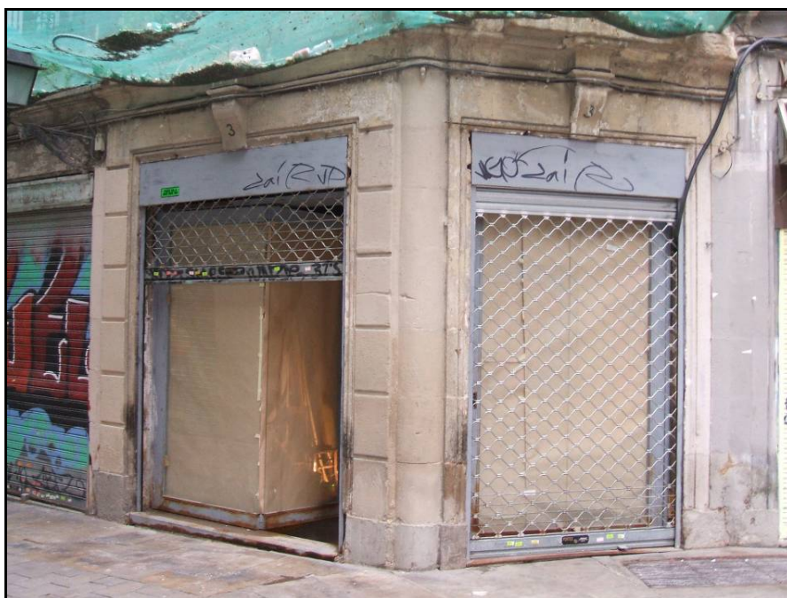
Fotografia 2: Vista de l'entrada als baixos del núm. 3 del carrer de Milans.
