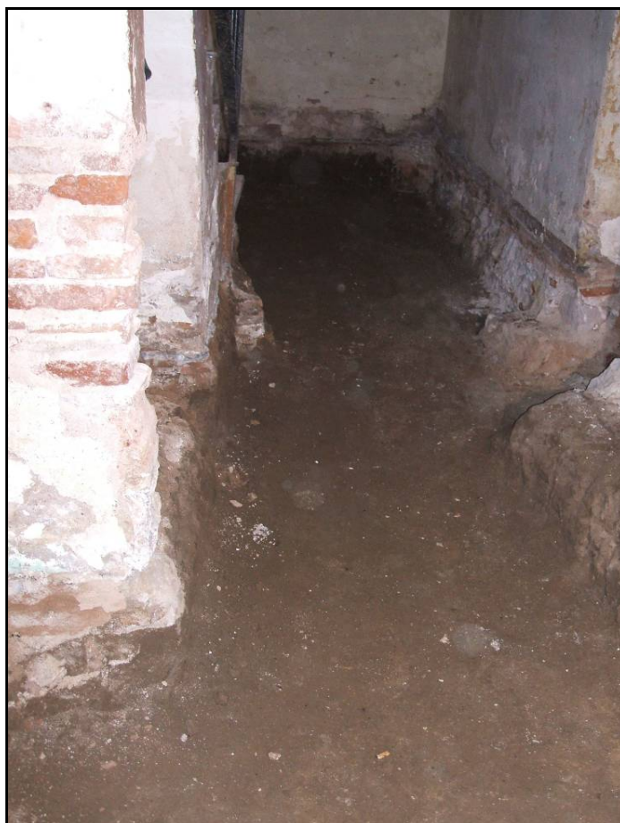
Fotografia 6: Vista general de l'H.2 al final del rebaix.
