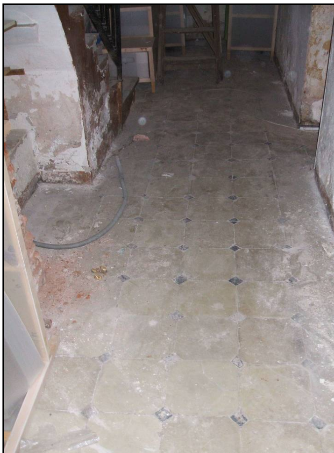
Fotografia 4: Vista de l'H.1 abans de començar el treballs de rebaix.
