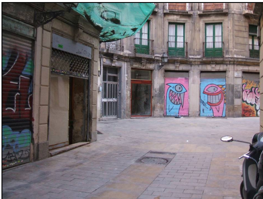
Fotografia 1: Vista general del tram del carrer de Milans on se situa la finca núm. 3.
